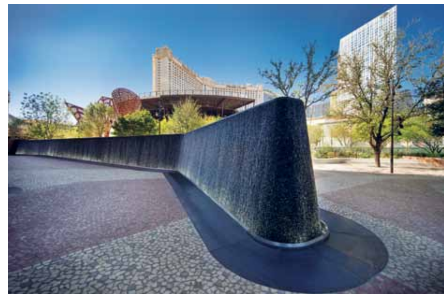
De waterwand gezien vanaf de Strip.
