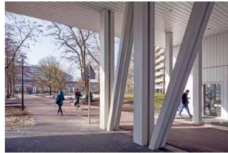
De nauwe tunneltjes hebben plaatsgemaakt voor ruime onderdoorgangen van twee verdiepingen.
