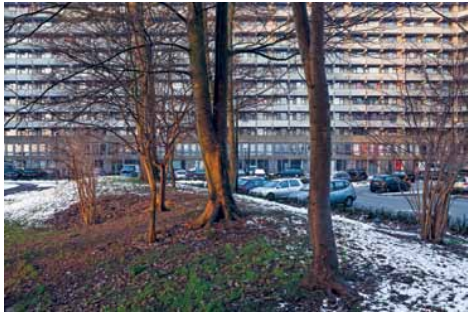
De auto's staan in de buitenruimte van Kleiburg, in plaats van in de parkeergarages die vroeger bij de honingraatflats hoorden.
