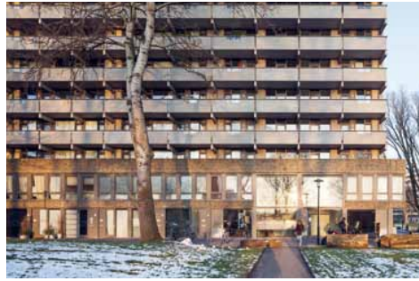
De plint heeft glazen puien waarachter woningen, fietsenbergingen en ateliers schuilgaan.
